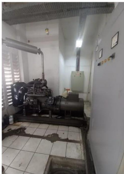
Foto 05: Grupo Gerador Diesel – 101 kw
