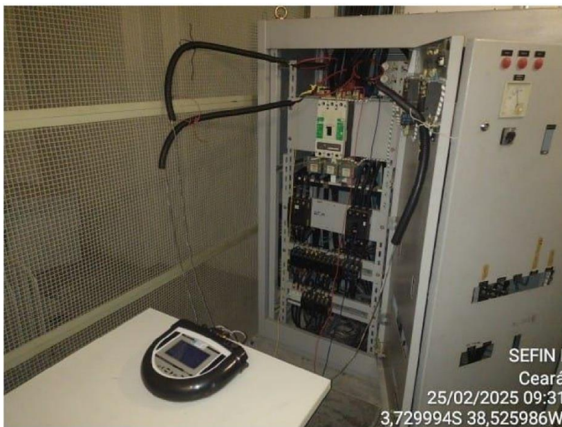
Foto 04: Analisador de Energia -Medição de Grandezas Elétricas no QGBT.
