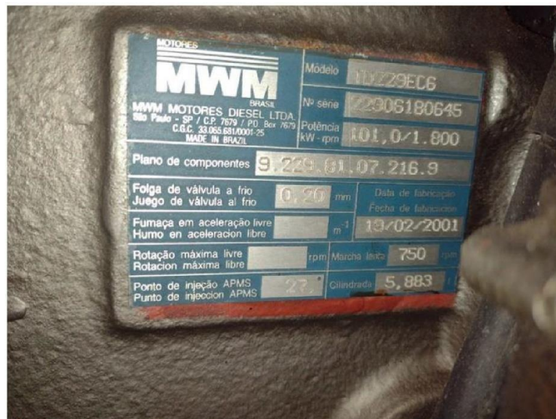
Foto 06: Grupo Gerador Diesel – Plaqueta de identificação.
