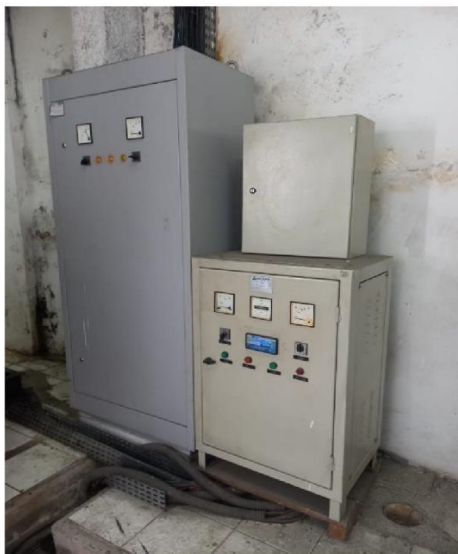
Foto 02: Quadro Geral de Baixa Tensão – QGBT.
