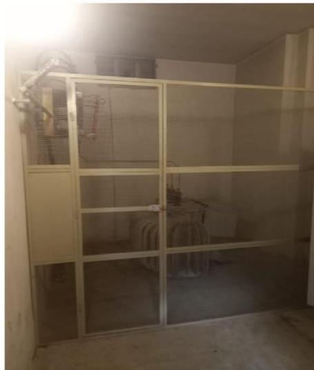
Foto 01: Vista frontal da Subestação, transformador a óleo e chave seccionadora.
