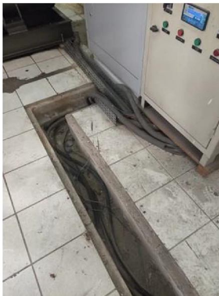
Foto 03: Canaleta, passagem de cabos interligando transformador – QGBT.
