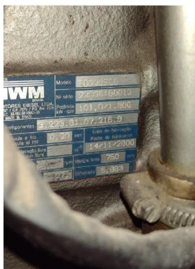
Foto 06: Grupo Gerador Diesel – Plaqueta de identificação.
