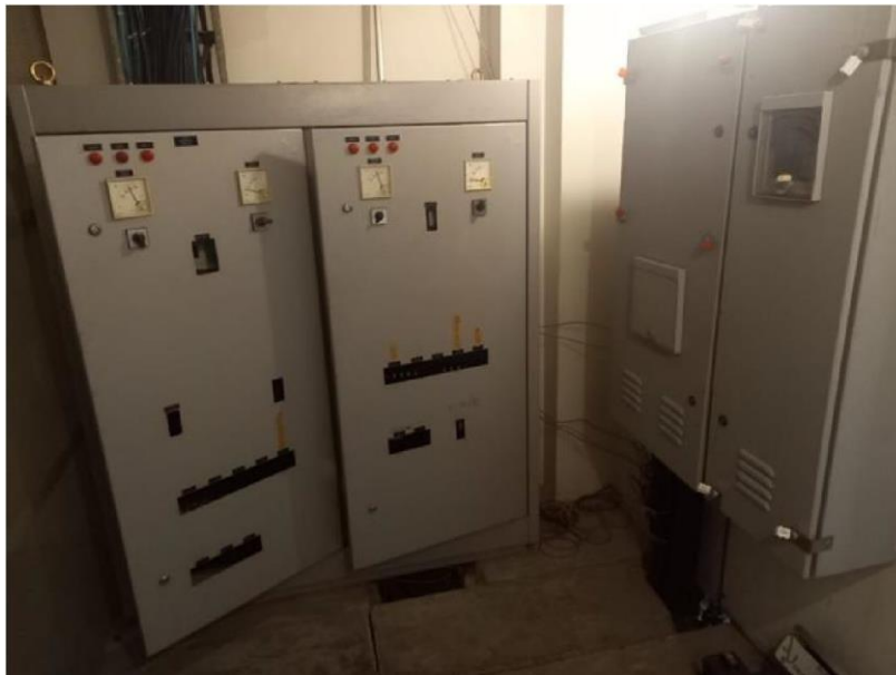
Foto 03: Quadro Geral de Baixa Tensão – QGBT.
