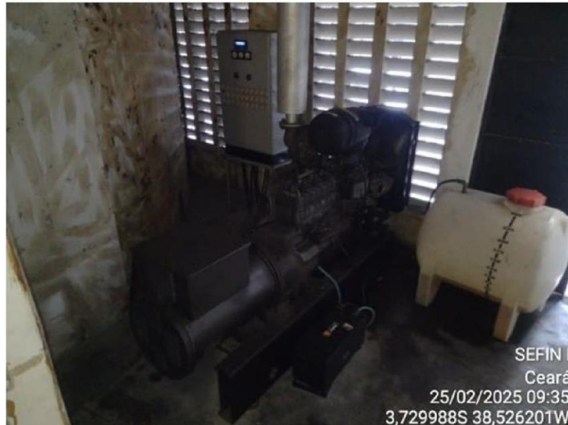
Foto 05: Grupo Gerador Diesel – 101 KW.
