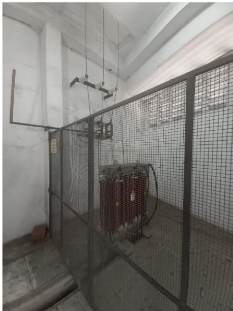
Foto 01: Vista da Subestação, transformador a seco e chave seccionadora
